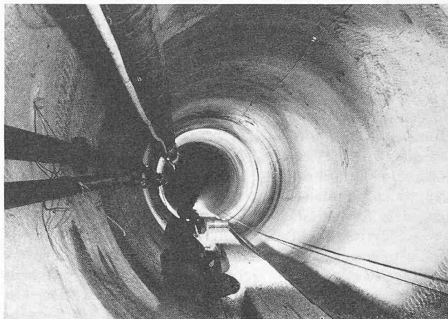
Bild 8. Ansicht des gebohrten Schachtes
