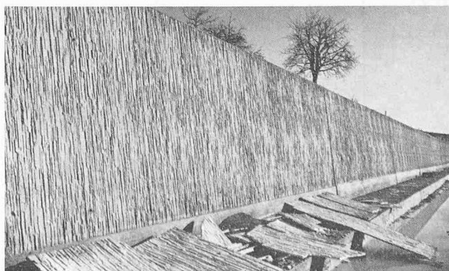
Nationalstrasse N 1: Stützmauer Hagenbuch ZH, Baujahr 1968. Am Boden liegen ausgeschaltete «Pre-Dur»-Platten
