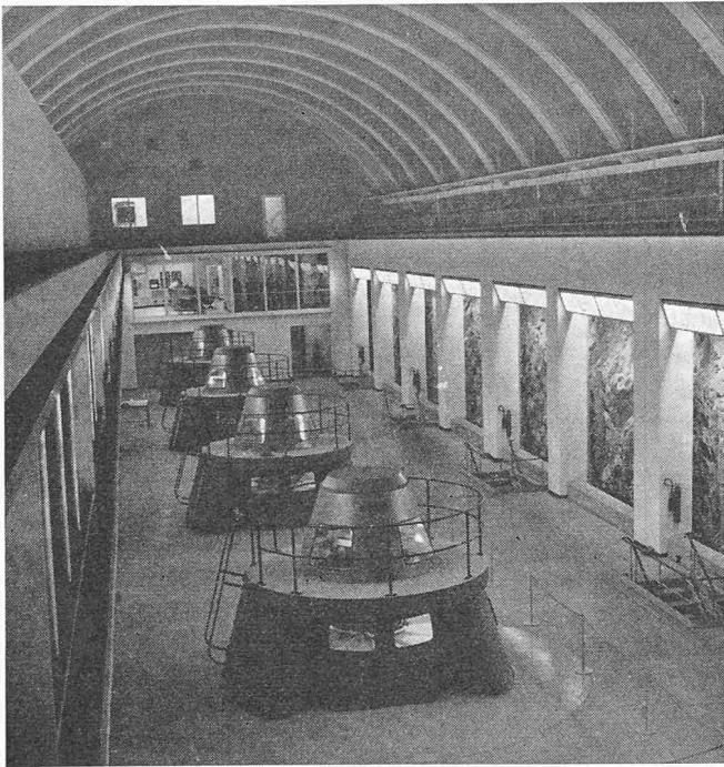
Bild 7. Blick in das Untergrund-Maschinenhaus des Tumut-2-Kraftwerkes. Leistung 4 \times 70 MW. Die Felswand der Kaverne ist hinter der Säulen sichtbar
