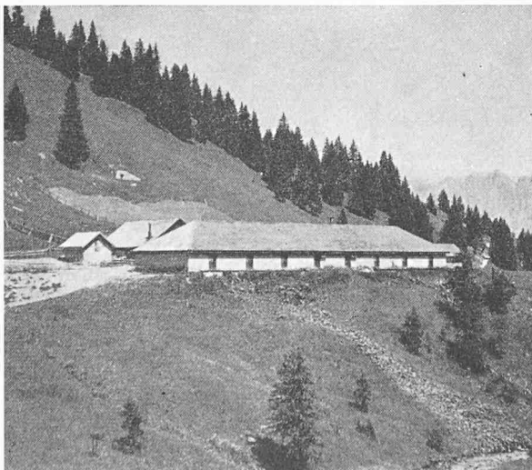
Bild 1. Querstall auf Alp Kohlschlag Untersäss, Gemeinde Mels, für 160 Grossvieheinheiten, erbaut 1893/94; Baukosten 13 000 Fr.
