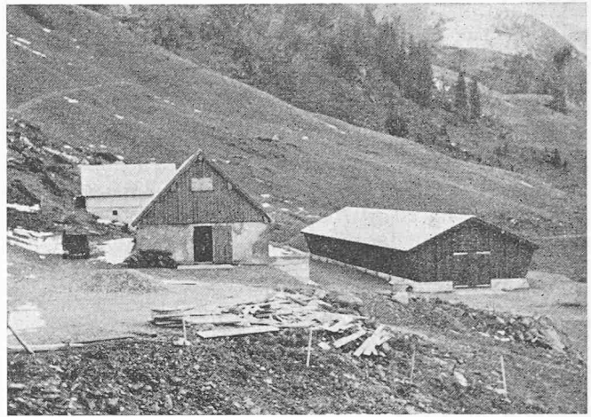
Bild 9. Gebäude auf Alp Seeben, 1620 m ü. M., Gemeinde Quarten. Links hinten die neue Sennhütte, davor in der Mitte der alte, umgebaute Stall für 45 m Lager, rechts der neue Normstall für 60 m Lager, Baujahr 1967. Kosten: Sennhütte 35 000 Fr., Stallumbau 49 000 Fr., neuer Normstall 66 000 Fr.
