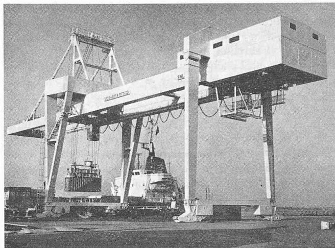
Bild 1. Ansicht des 30-t-Container-Umschlagkranes im Hafen von Harwich
