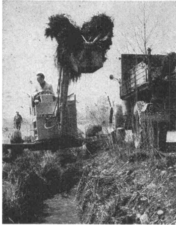
Arbeit mit dem Grabenlöffel
