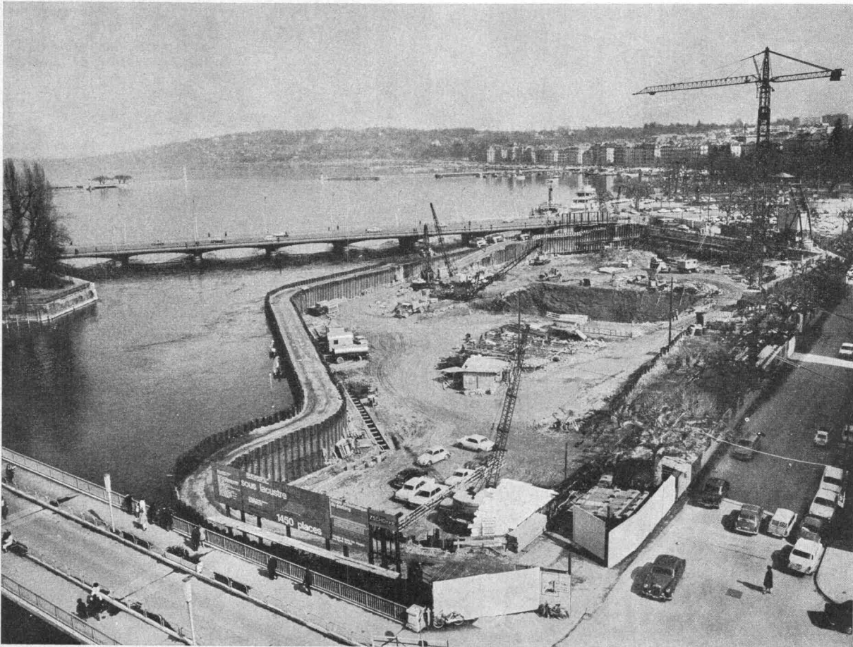
Unterwassergarage Pont du Mont-Blanc, Genf
