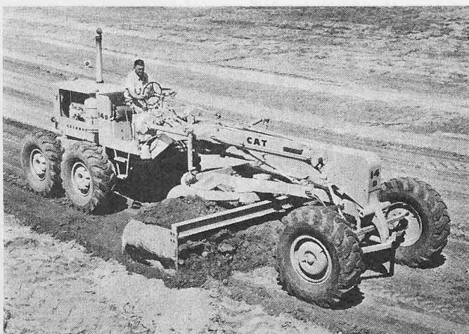
Bild 1. Der Scharkübel ohne Boden durchschneidet Erhöhungen und schiebt das Erdreich nach vorne. Bei Vertiefungen fällt das Erdreich als Auffüllmaterial heraus
