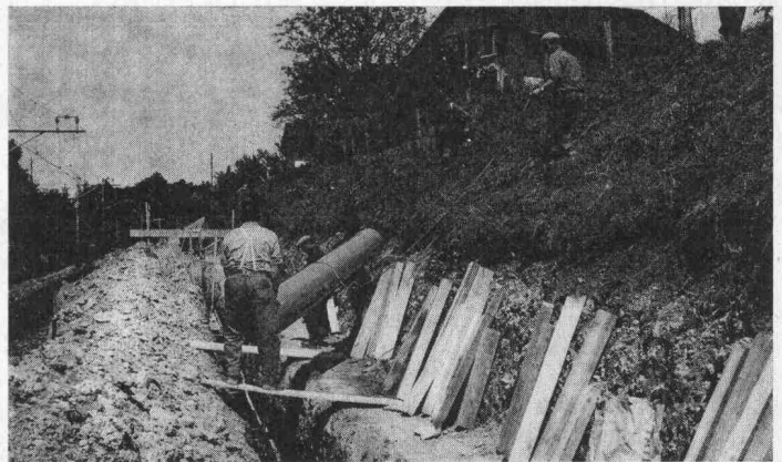
KALIDUR-Kanalisationsrohre, verlegt im Bahneinschnitt
