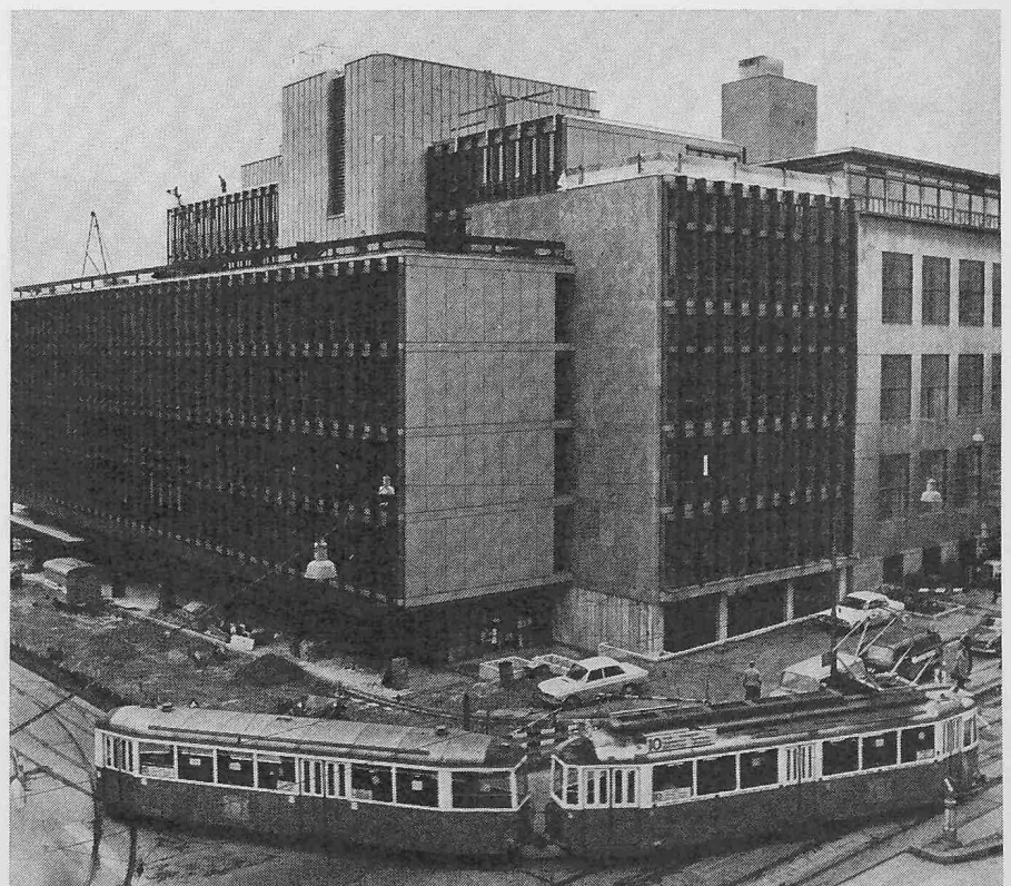
Bild 1. Ansicht des Neubaus des Maschinenlaboratoriums II aus Südosten
