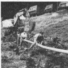
Kanalisation Schwyz: Rothenturm
