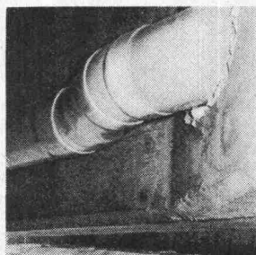
Ablauf Autobahn Vengeron
