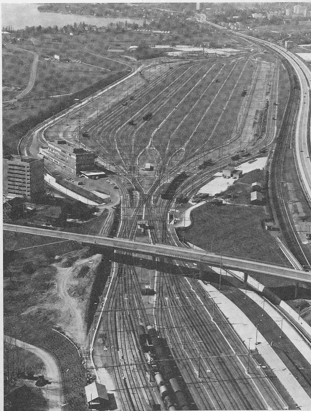
Bild 1. Fliegeraufnahme von Lausanne-Triage, bestehend aus Einfahrgruppe, Ablaufberg und Richtungsfächer; rechts Autobahn und SBB-Linie Lausanne—Genf; links Rückfahrgeleise nach Lausanne, Dienstgebäude mit Funkantenne und Personalwohnhaus; hinten Mitte Werkstatt im Rohbau
