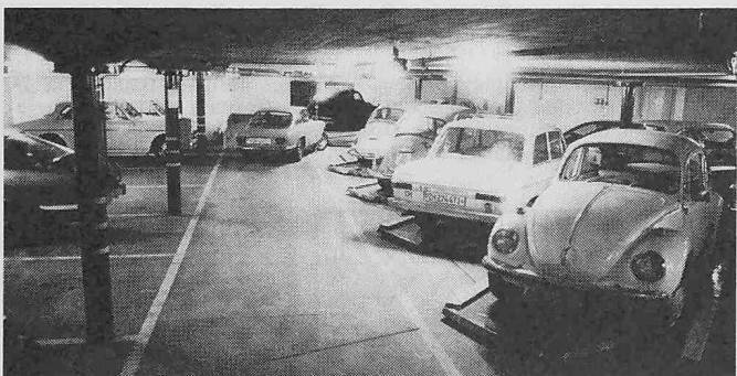
Bild 3. Einfahren auf eine Plattform. Sie ist von den Nachbarplattformen automatisch frei gestellt und im Winkel von 45° zum Fahrer hin gerichtet
