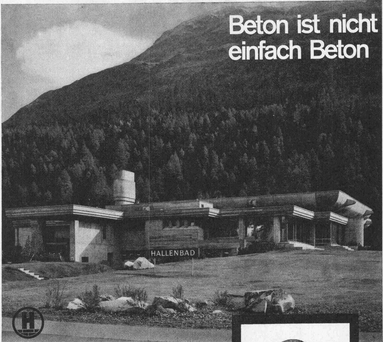
Alpines Hallenbad in St. Moritz Planung: R. Obrist und A. Theus, Architekten, St. Moritz Statik: Jenatsch + Hegland, Ingenieure, Chur Bauausführung: Nicol. Hartmann + Co. AG, Bauunternehmung, St. Moritz
