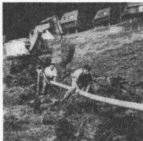
Kanalisation Schwyz: Rothenturm
