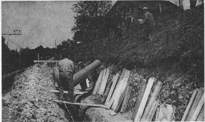
KALIDUR-Kanalisationsrohre, verlegt im Bahneinschnitt
