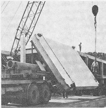
Bild 2. Kippen einer Deckenplatte am Transportfahrzeugstell (Gewicht der Platte rund 12 t)
