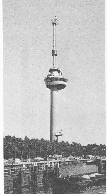
Bild 3. Nach der Montage des neuen Turmes hat der Euromast eine Höhe von 175 m
