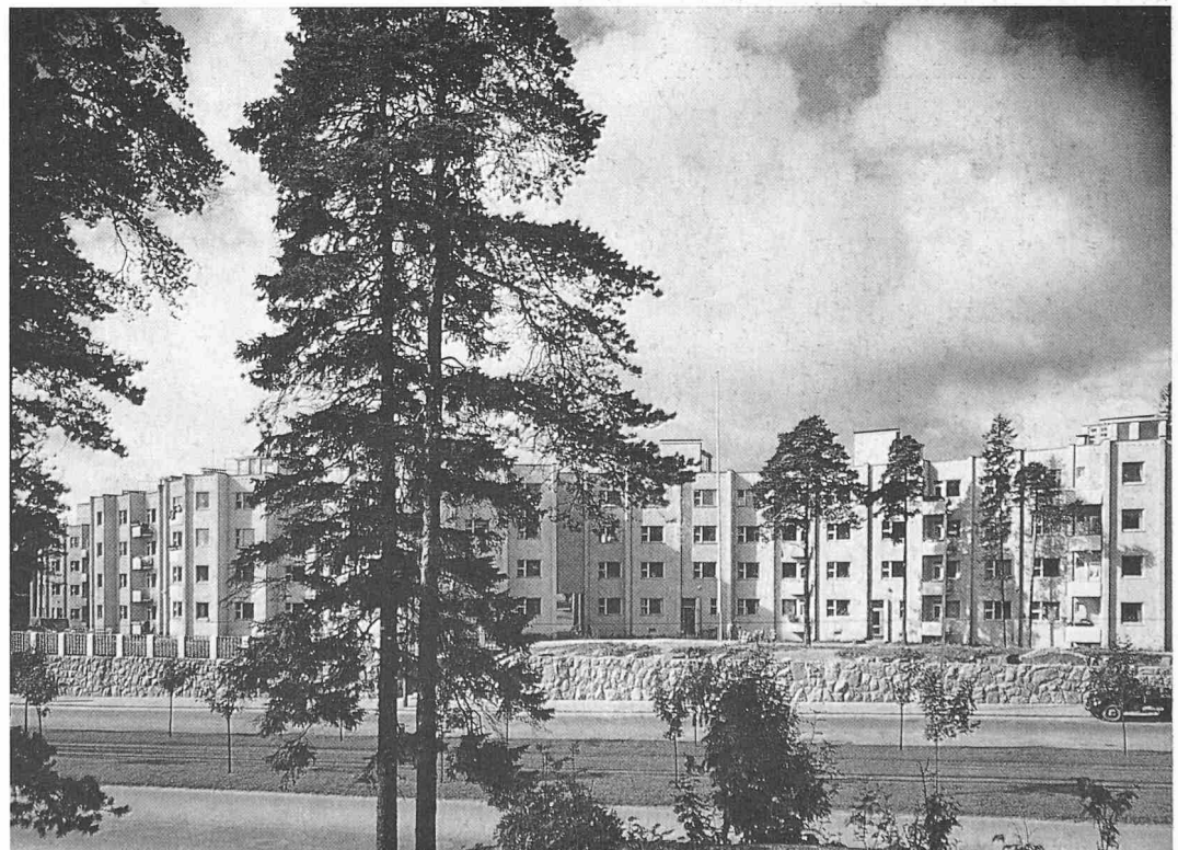
Bild 8. Yrjö Lindgren: Serpentinenhäuser, Helsinki, 1951
