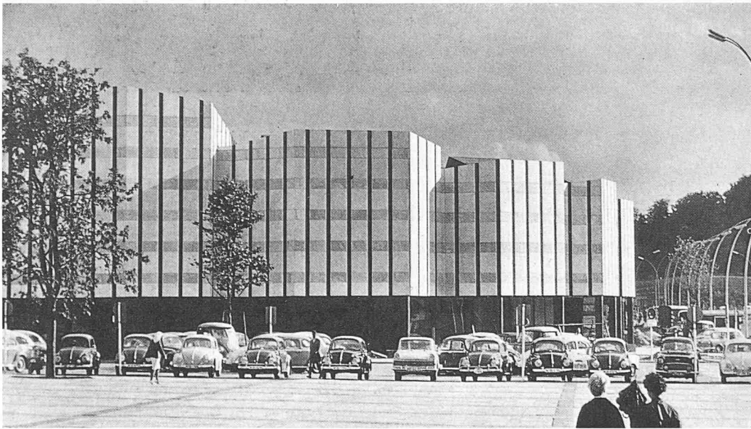
Bild 11. Alvar Aalto: Kulturzentrum in Wolfsburg, 1962
