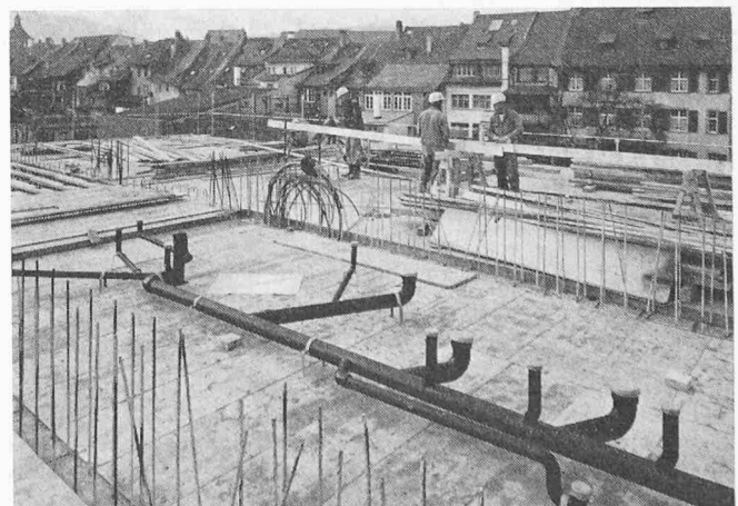
Bild 1. Vorgefertigte Kunststoff-Ablaufleitungen aus Hartpolyäthylen (Akatherm) auf einer Schalung montiert
