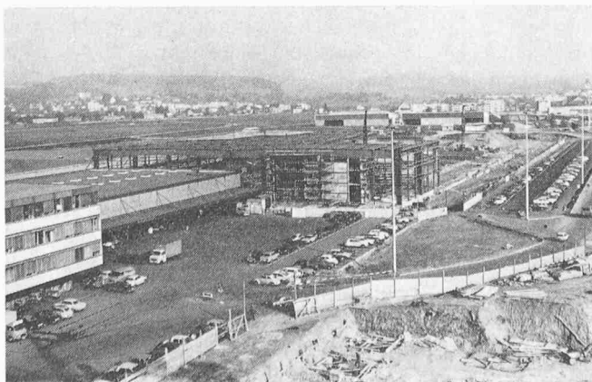
Ansicht des im Bau befindlichen Frachthofs Ost
