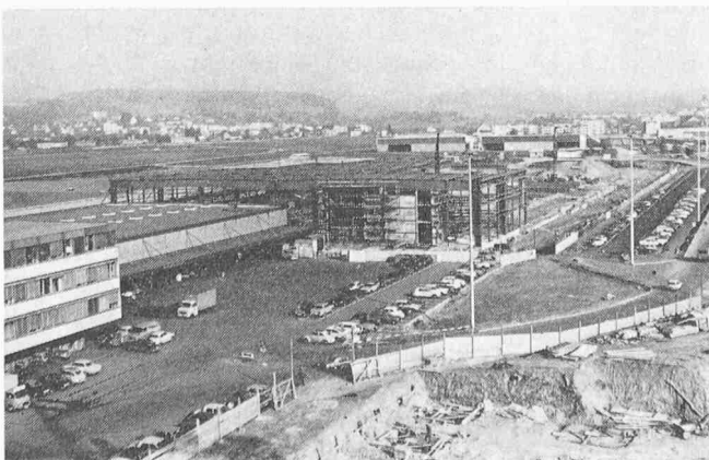
Ansicht des im Bau befindlichen Frachthofs Ost
