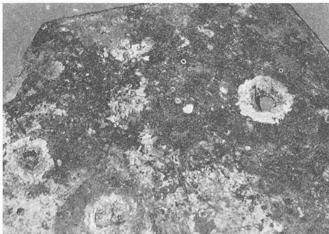
Bild 1. Perforation eines erdverlegten Stahltanks von innen
