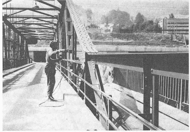
Bild 7. Zweischicht-Lackiersystem für Stahlkonstruktionen
