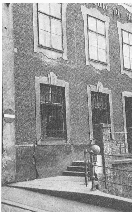
Bild 3. Ungleiche Setzungen am Ursulinen-Kloster
