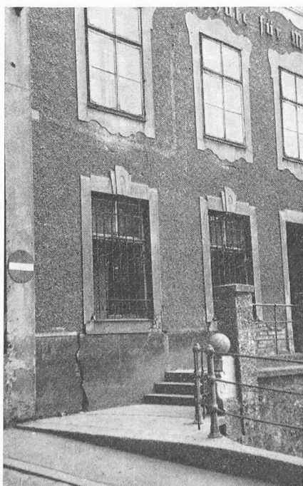
Bild 3. Ungleiche Setzungen am Ursulinen-Kloster
