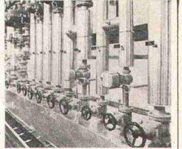
glatte und homogene Oberfläche im Boilerinneren verhindert zudem den starken Kalkansatz bei hartem Wasser. Die einfache Konstruktion der Strebel Hochleistungsboiler gewährleistet die Besichtigung und Kontrolle der gesamten Heizfläche. Das Strebel Boilersystem H für Separataufstellung ermöglicht die Verwendung der Hochleistungsboiler Typ H überall, unabhängig vom Standort des Heizkessels. Strebel Heizkessel und BICALOR-Kombinationen sind dank hoher spezifischer Leistung sehr kompakt.
