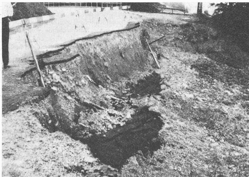
Bild 1. Strasse am Hang. Fast die Hälfte der Strasse rutscht plötzlich ab.
