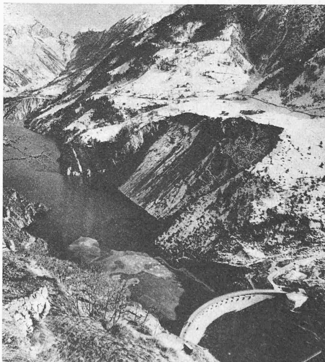
Bild 6. Erste grössere Felsrutschung von rund 700 000 m 3 in der Nähe der Sperrstelle auf der linken Talseite, oberwasserseitig
