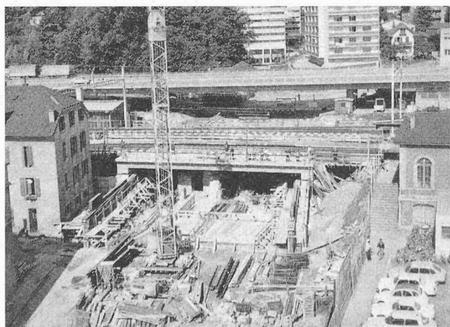
Construction des dalles aval, vue après ripage
