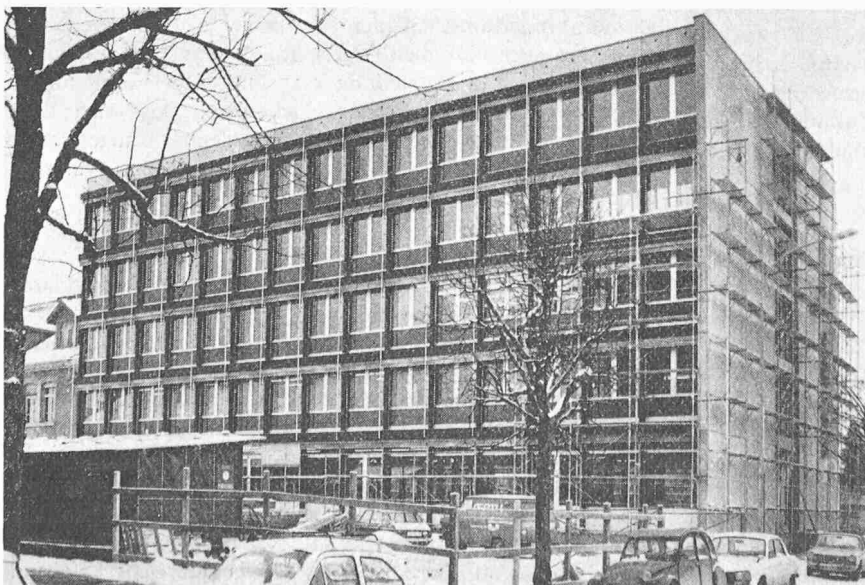
Fig. 1. Vue de la façade sud, 1ère étape
