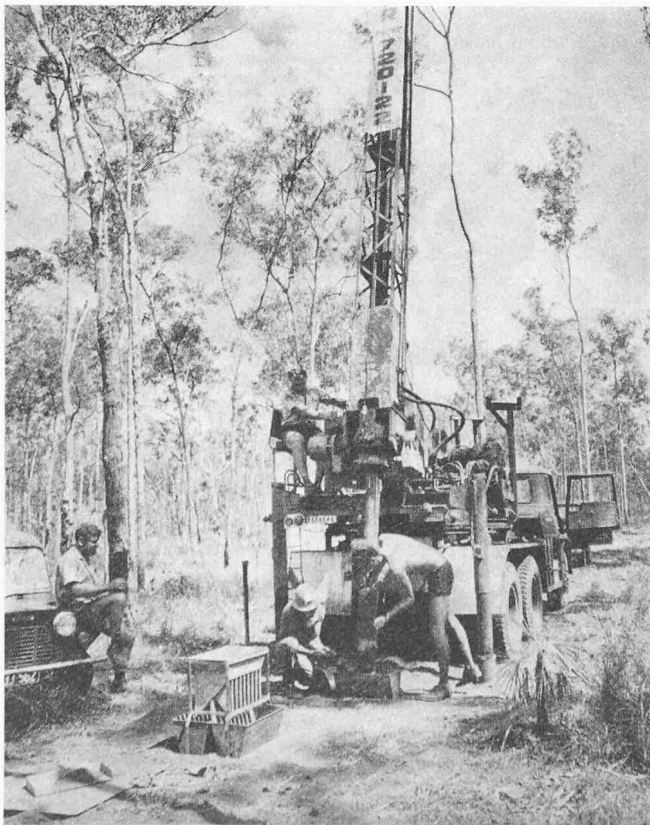
Bild 5. Prospektion, Bohren von Bauxitproben im Jahre 1966
