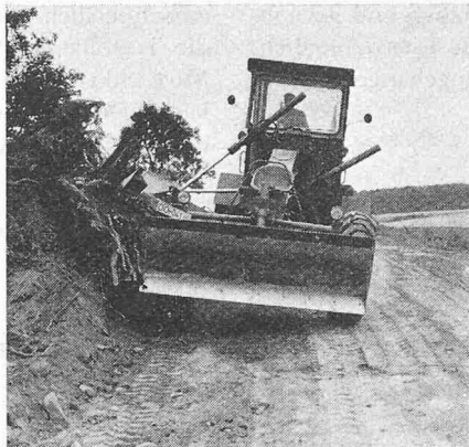
Bild 9. Herausreissen und Abschieben des Stubbens
