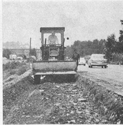
Bild 5. Fertigprofilierung der Auskoffierung
