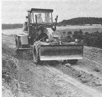
Bild 10. Fertigprofilieren mit der Hauptschar
