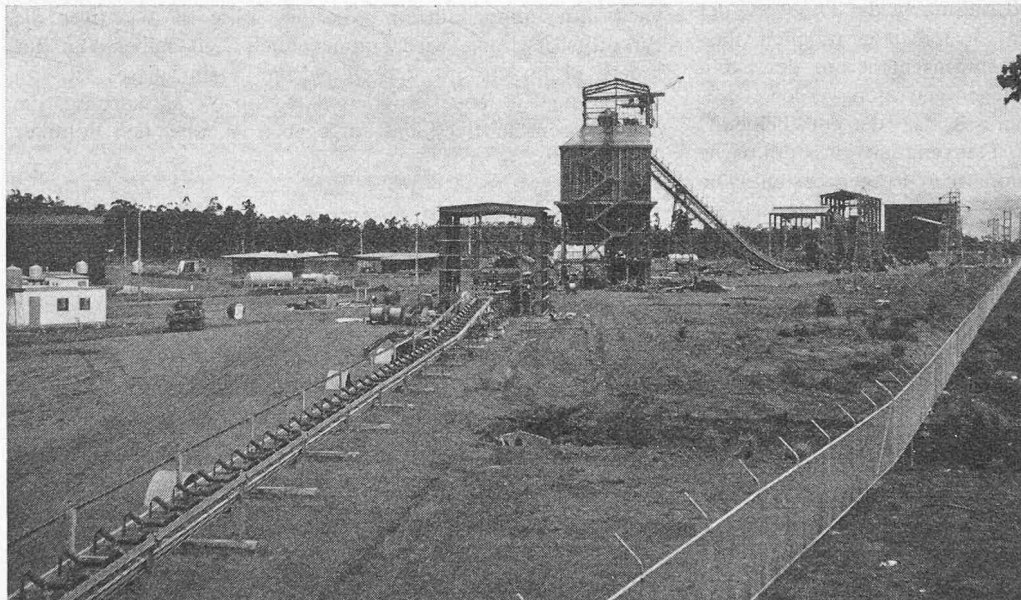
Bild 2. Brecher und Siebstation
