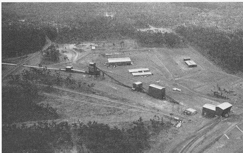
Bild 3. Flugaufnahme von Brecher und Siebstation
