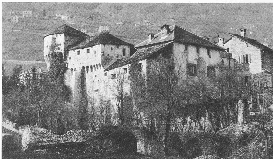
Locarno. Das Kastell. Aufnahme von 1910 vor der Wiederherstellung
