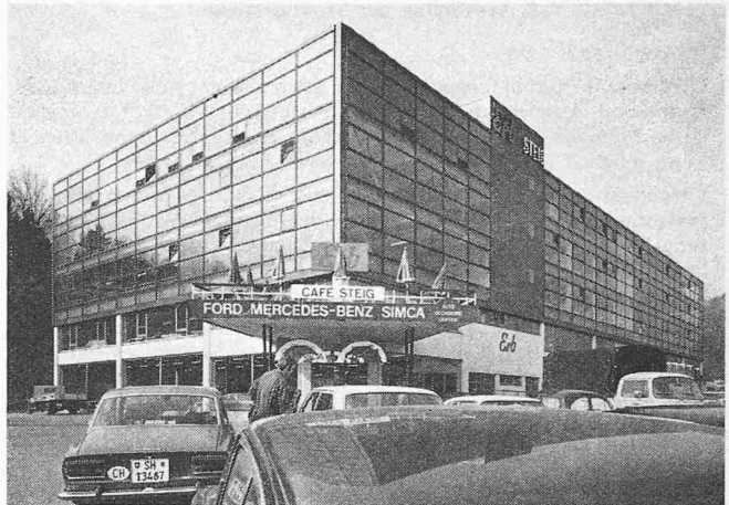
Bild 19. Der fertige Bau in seiner klaren Form. Autocenter Steig. Bauherr: H. Erb AG, Winterthur; Ingenieur und Architekt: Andrychowsky & Stutz, Ingenieurbüro, Winterthur; Stahlkonstruktion: Geilinger Stahlbau AG, Winterthur
