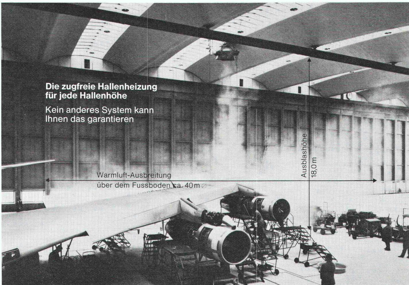
Diese Aufnahme zeigt deutlich, wie sich die Wärmeluft über dem Fussboden (und nicht an der Decke) ausbreitet.
