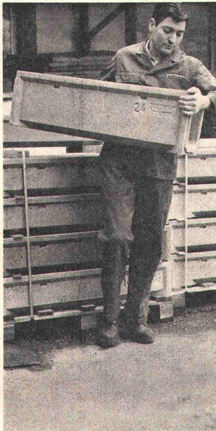
frost- und chemikalienbeständig und können nicht rosten. Sie haben eine glatte Oberfläche und einen günstigen Querschnitt: Das Wasser fliesst rascher ab, und die Rinne reinigt sich selbst.
