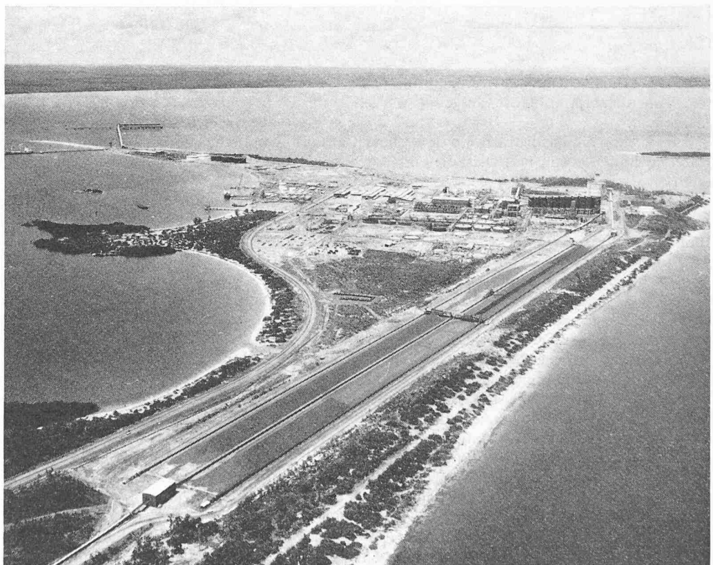
Bild 3. Tonerdefabrik auf der Halbinsel «Dundas Point»
