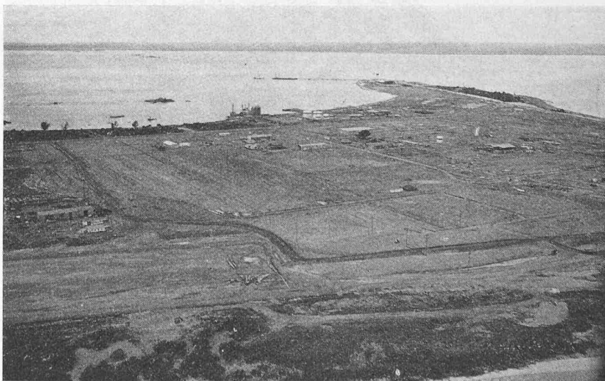
Bild 5. Planierungsarbeiten, Stand: März 1970
