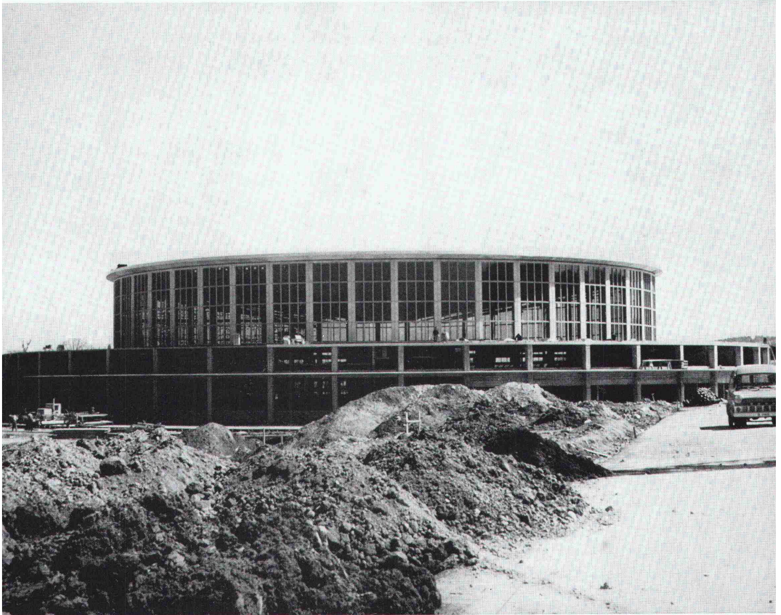
Rundhalle System Züblin für den AMP Grolle
