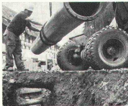
**Druckrohre aus duktilem Gusseisen\***
