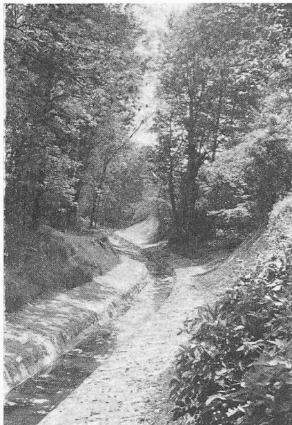
Bild 4. Korrektur des Altstätter Stadtbaches. Gepflästerte Niederwasserrinne. Der alte, schöne Baumbestand wurde bei den Arbeiten geschützt und blieb erhalten. Melioration der Rheinebene
