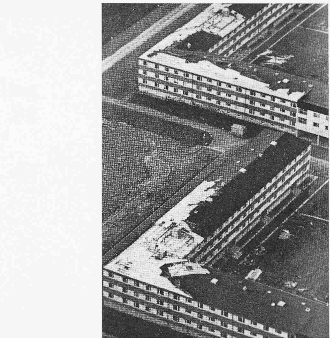
Bild 11. Typische Schäden, Anströmung über die linke Hausecke
