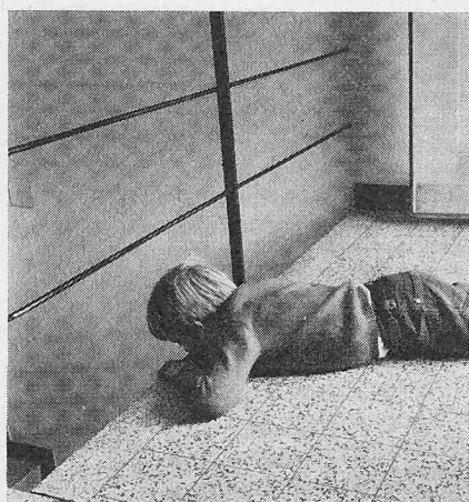
Bild 2. Der vierjährige Knabe betrat in Begleitung seiner Mutter das Treppenhaus, stolperte aber auf der Türschwelle, kam zu Fall und rutschte unter dem Geländer hindurch. Er stürzte in freiem Fall 12 m in die Tiefe
