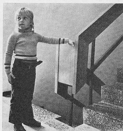
Bild 3. Das fünfeinhalbjährige Mädchen glitt auf der Treppe aus und rutschte unter dem Geländer hindurch. Es fiel 6 m ins Erdgeschoss hinunter und schlug während des Falles verschiedentlich auf die Treppengeländer auf
