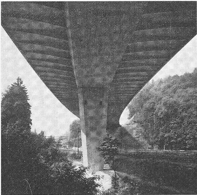
Nationalstrasse N1, Bauwerk Nr. 27, Autobahnbrücke Hammermühle Kemptthal, Variante Schmidt/Locher, erbaut 1970 bis 1973
