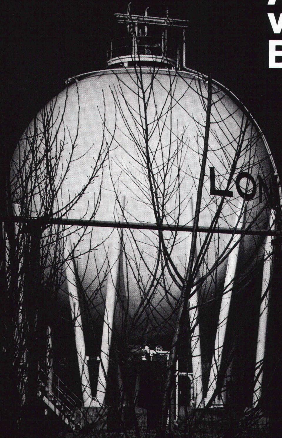
Hochwertige Werkstoffe, besonders entwickelte Schweissverfahren und neuzeitliche, zerstörungsfreie Prüfmethode ermöglichen den Bau grosser Kugelbehälter für Stadtgas und Flüssiggase. Buss AG, Basel
