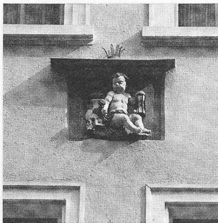
Das Hauszeichen am erneuerten steinernen Kindli: Der Ausschnitt zeigt die subtile handwerkliche Restaurationsarbeit
