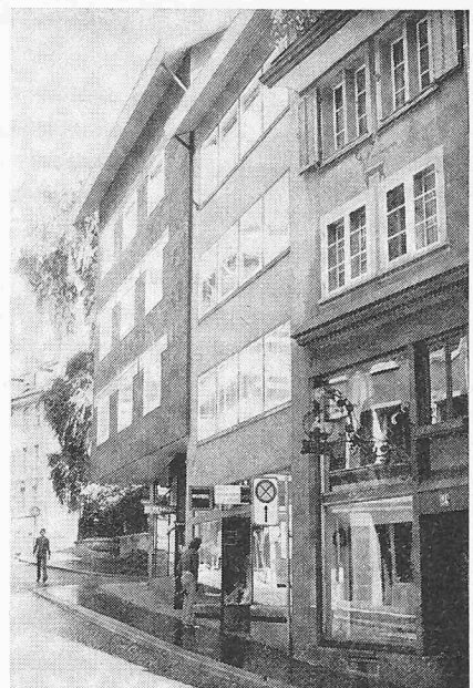
Das 1954/56 erstellte Doppelhaus Nr. 28 am oberen Neumarkt (südliche Strassenseite). Rechts das Damhirschli (Nr. 24, Stadtbesitz)
