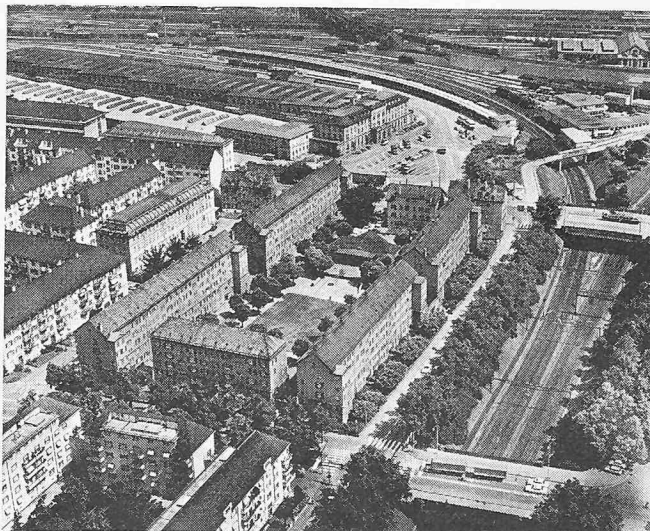
Die zur späteren Sanierung vorgesehene Wohnkolonie «Erismannhof» in Zürich-Aussersihl (erbaut 1926, 170 Wohnungen)
