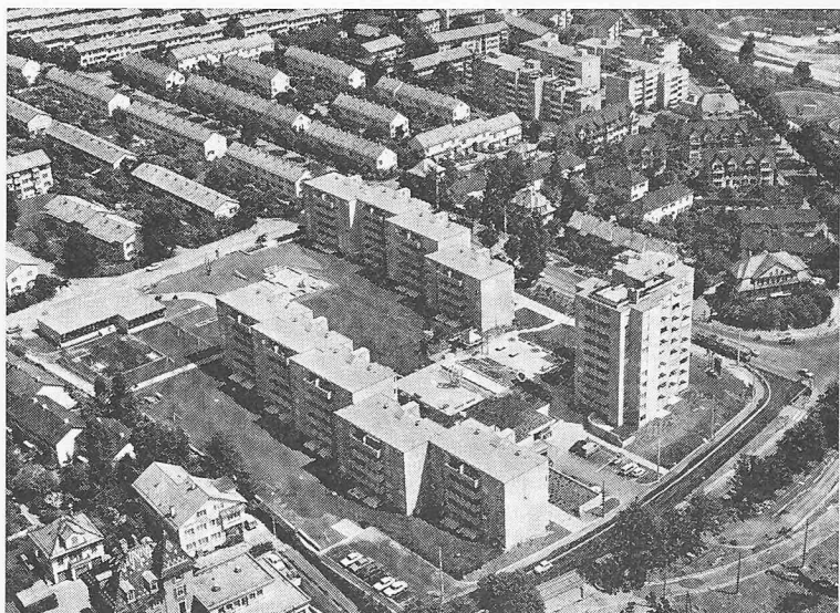
Rechts: Die neue Arealüberbauung «Utohof» kurz nach der etappenweisen Fertigstellung. Das Bauareal misst rd. 20 000 m 2
