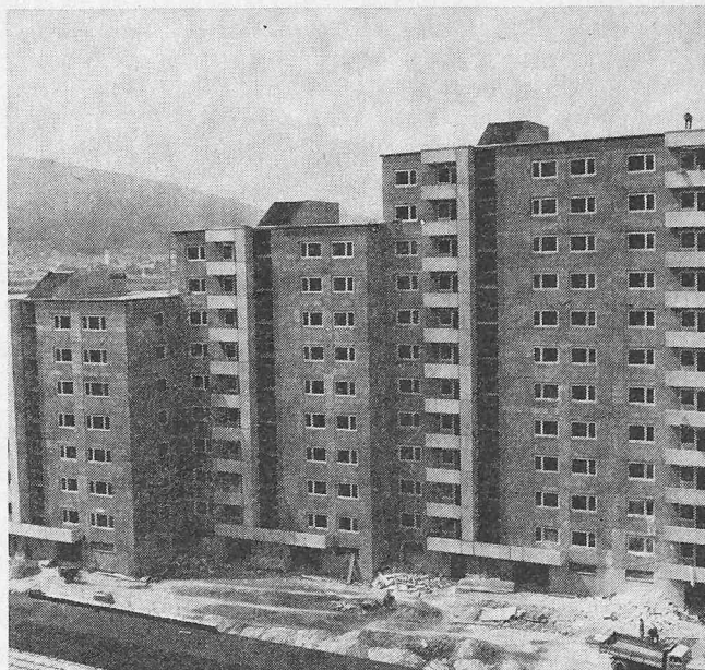
Velox-Rohbau für Olympia-Dorf 1976, Innsbruck
