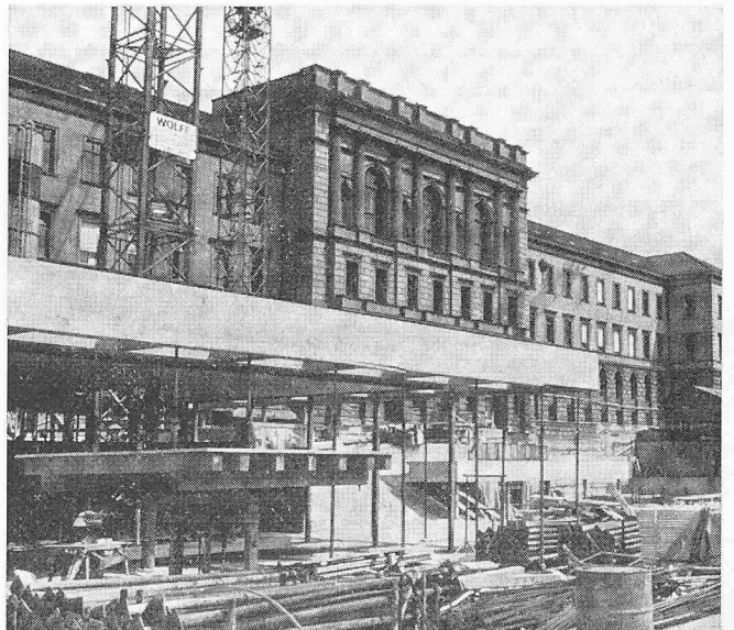
Der «GEP-Pavillon» nimmt bauliche Gestalt an. Dahinter die nahezu ursprüngliche Westfassade von Gottfried Semper
